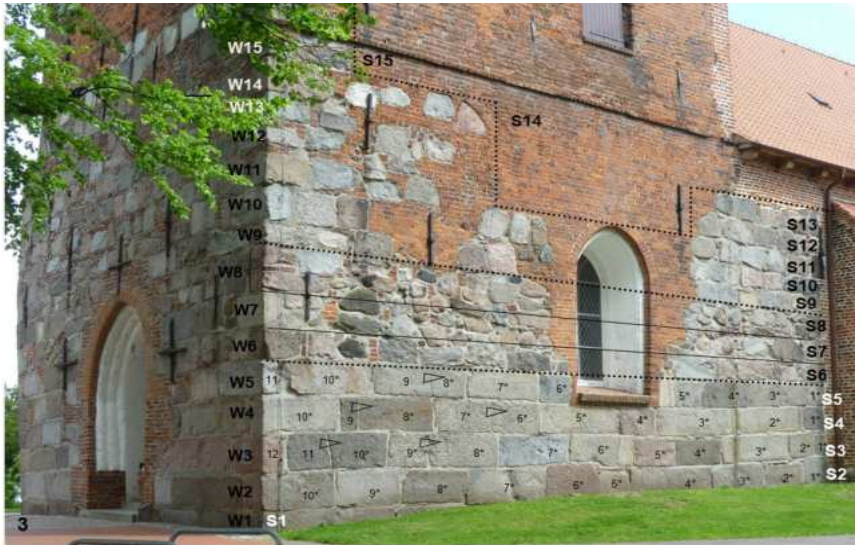
Abb. 3. Südwand des Westbaus, Zonen 1 und 2 in der Übersicht. Ausgehend von der östlichen Baufuge, sind hier nur die quaderähnlich zugerichteten Findlinge der 5 unteren Schichten nummeriert. Teile zerbrochener oder gespaltenen Steine, die eindeutig zusammengehören, sind mit einem Dreieck verbunden. * = Bildstein, Einzelheiten s. Text.
